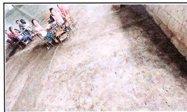
Foto 6: Culminación de piso.
