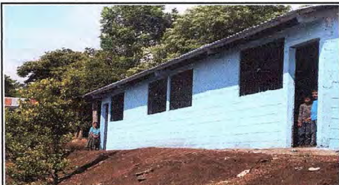
Foto1: Aulas terminadas satisfactoriamente en su estructura.
