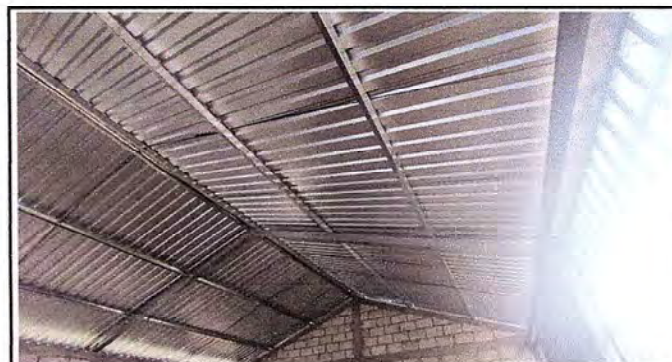
Foto 4: Vista del interior del entechado y la estructura de las dos aulas terminadas .
