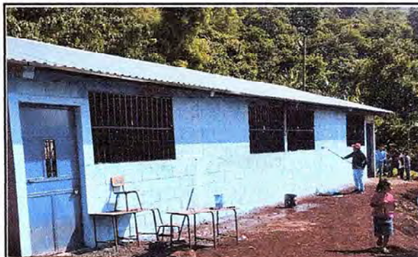
Foto 2: Vista de las puertas instaladas.
