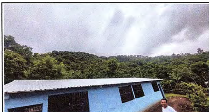
Foto 3: Vista del entechado de las dos aulas mejoradas.
