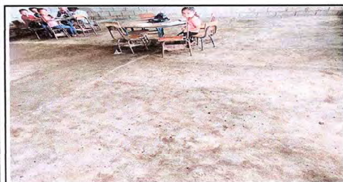
Foto 5: Vista de la culminación del piso de las aulas.
